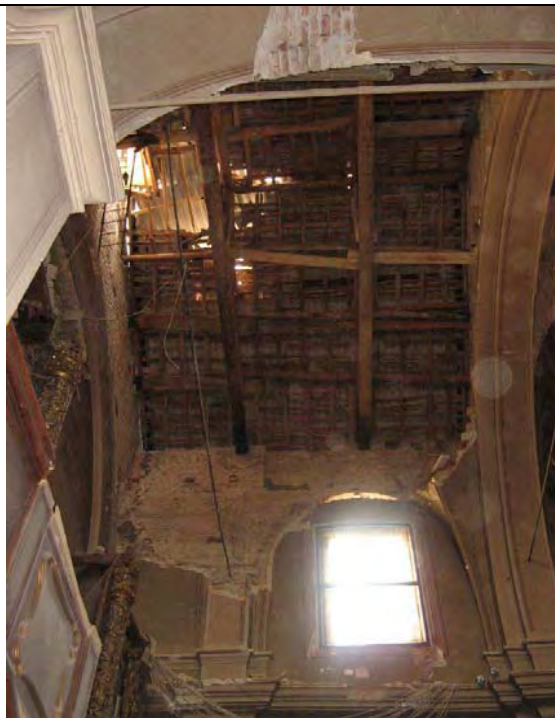
Crollo della volta di facciata
